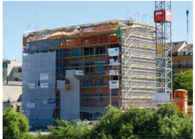
Bank-Neubau an der Meret Oppenheim-Strasse, Juni 2016
